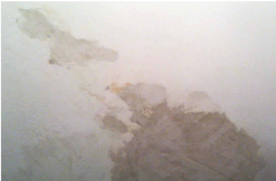
Mancha de humedad en la pared de una vivienda debida a pérdidas en las cañerías del agua.
